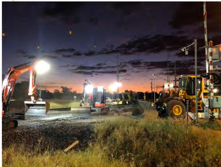
2x 5T-Bagger arbeiten zusammen mit Ladern, um den Schotter vor der Erneuerung des Gleises aufzufüllen und zu verpacken.
