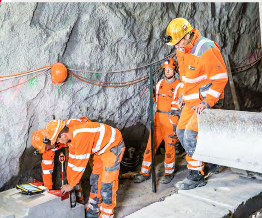
**MEHR ALS DIE HÄLFTE DER 115 TUNNEL IM STRECKENNETZ DER RHÄTISCHEN BAHN (RHB) MÜSSEN AUFGRUND IHRES ALTERS AKTUELL SANIERT WERDEN. HIERFÜR ENTWICKELTE DER BAHNBETREIBER EIGENS EIN NEUES, STANDARDISIERTES INSTANDSETZUNGSVERFAHREN: DIE „NORMALBAUWEISE TUNNEL“. DIESE VERBESSERT QUALITÄT UND WIRTSCHAFTLICHKEIT DER TUNNELSANIERUNGEN UND ERHÖHT DEN SICHERHEITSSTANDARD SOWIE DIE LEBENSDAUER DER TUNNEL AUF 70 BIS 100 JAHRE.**
