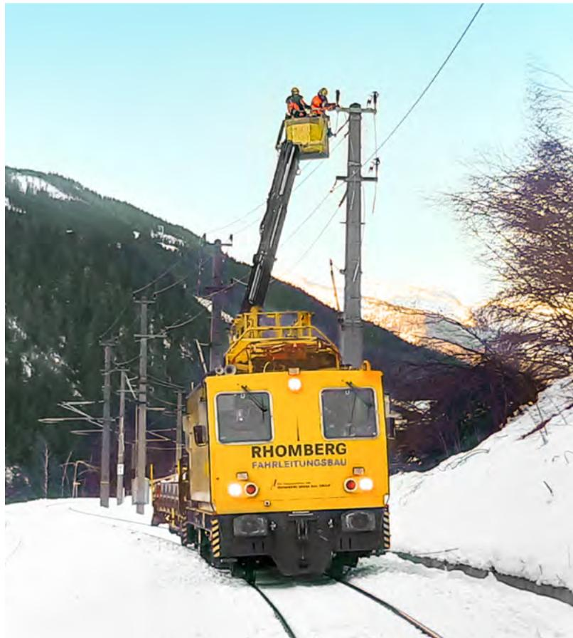
die Schäden beheben. 30 zum Teil schwer beschädigte Fahrleitungsausleger wurden demontiert und durch neue ersetzt. Rund 1,5 Kilometer defekte Oberleitungskette musste getauscht werden. Fast fünf Kilometer Spitzen- und Rückleiterseile wurden durch neue ersetzt und in ca. 130 Stützpunkten eingebunden.
