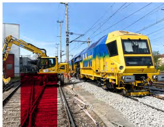
mit den Zweiwegebaggern der Bahnbau Wels abgetragen und rund 5 000 Tonnen Kantkorn 70/150 sowie 2 500 Tonnen Gleisschotter wieder eingebaut.
